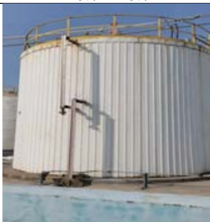
甲基丙烯酸甲酯储罐
